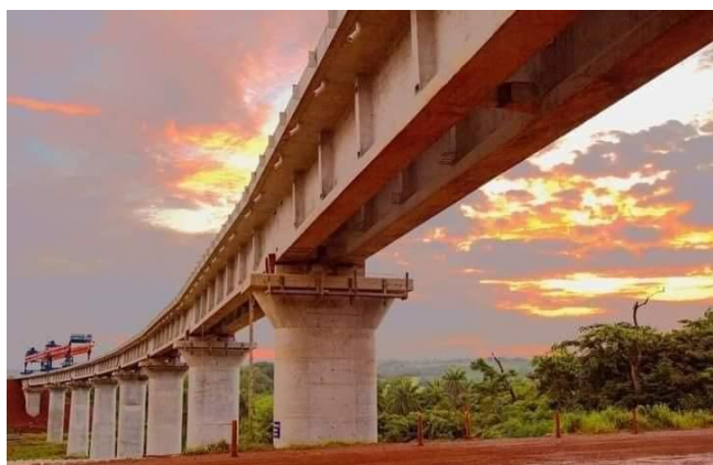
Le chemin de fer de la SMB en construction à Boké
