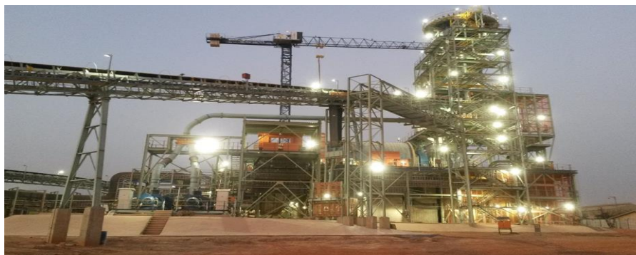
La nouvelle Usine de la SAG à Koron.
