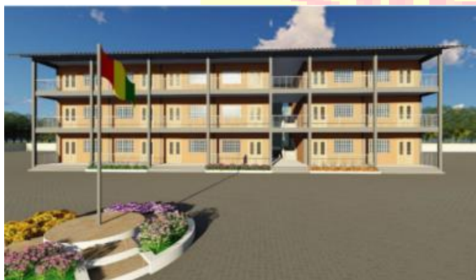
Lycée d'excellence offert par la SMD aux communautés
